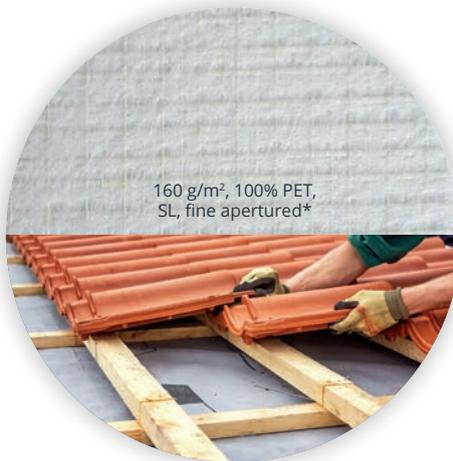
Wir entwickeln unsere Vliesstoffe unter der Berücksichtigung der ETAG005. Sie erfüllen die Mindesthaltbarkeit von 60 Jahren und der Rohstoff Polyester sichert die nötige alkalische Beständigkeit.
